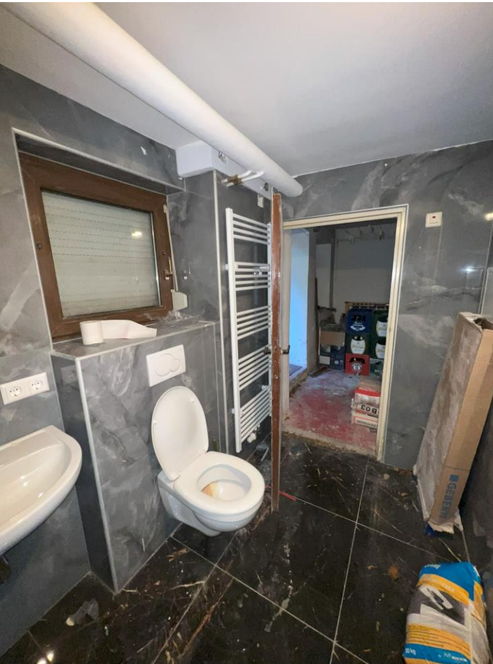
Badezimmer und Zugang zum Heizraum und zum Parkplatz
